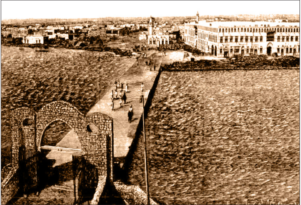
لوحة لبوابة غردون والرصيف الرابط بين المدينة والقيف - عن طارق أحمد حكيم
