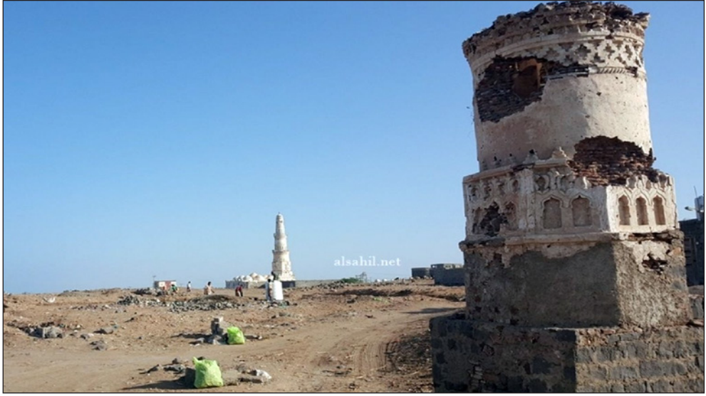
بقايا القلعة القديمة في المُخَا
