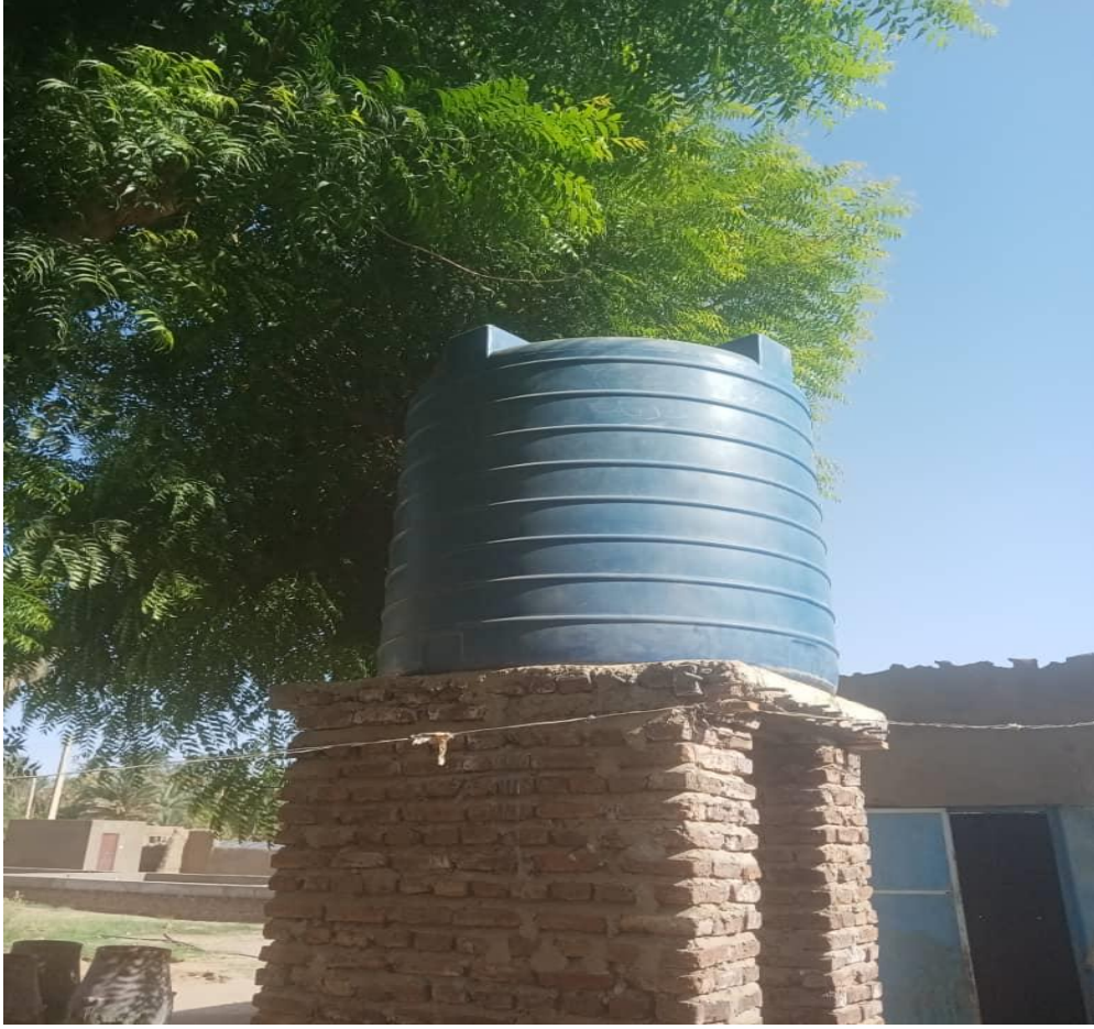
صورة رقم (17)، صهريج (خزان ماء) مدرسة القدار المتوسطة بنات
